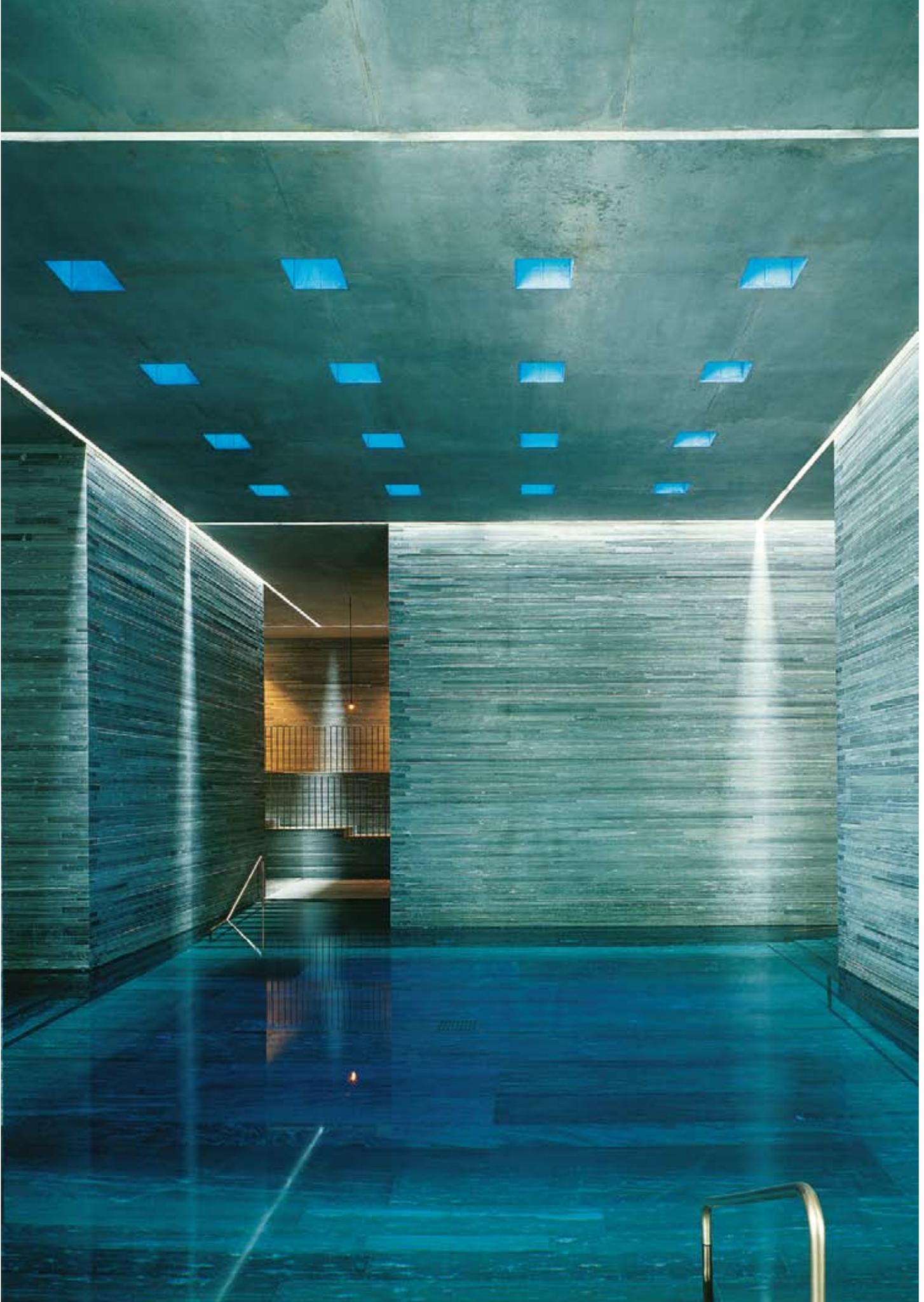
Man nehme graugrünen Quarzit (Valser Gneis) als Baustoff, fräse daraus 60.000 einzelne Platten (von maximal 6,3 cm Stärke), lege sie in vielen Schichten (ohne Verwendung von Mörtel) aufeinander und forme daraus Mauern – und fertig ist ein Sinnbild der umgebenden Bergnatur.
